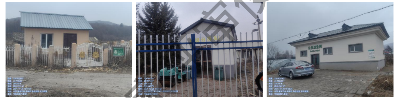
图 2-3 水井泵房（左）、垃圾分拣站（中）、公厕（右）
