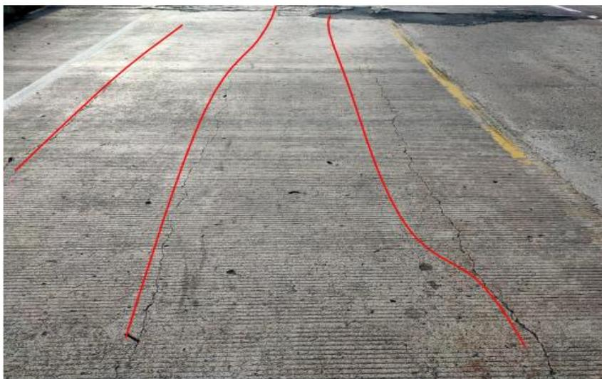
1#跨桥面铺装纵向裂缝
